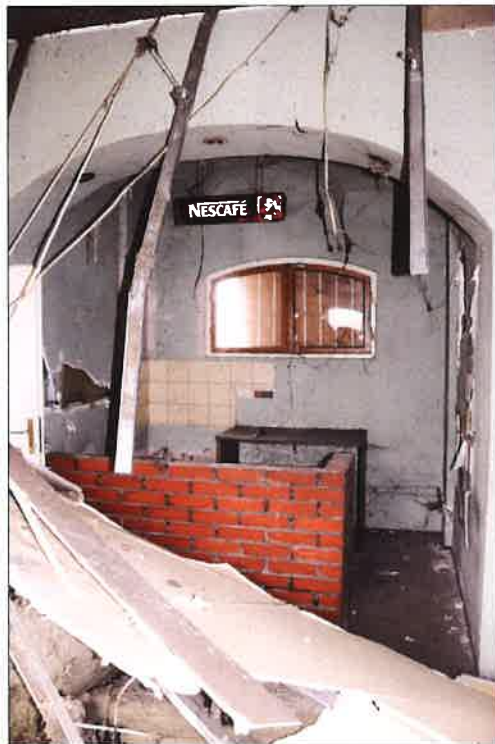
Wtórnie wykonana zabudowa z płyt karton-gips z wydzieleniem nowymi ścianami dwóch pomieszczeń i zakryciem oryginalnego stropu żelbetowego przez sufit podwieszany - obecnie zarwany. (fot. Jakub Andrzejewski, 2021 r.)
