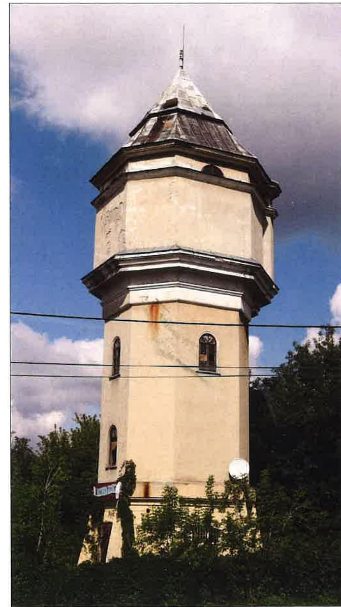
Widok budynku od strony ul. Orlej, od strony południowo-wschodniej. (fot. Jakub Andrzejewski, 2021 r.)
