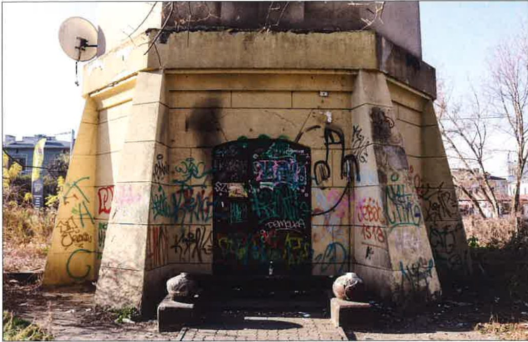
Wejście do budynku od strony północno-wschodniej, z widocznymi częściowo zachowanymi oryginalnymi schodami wejściowymi. (fot. Jakub Andrzejewski, 2021 r.)
