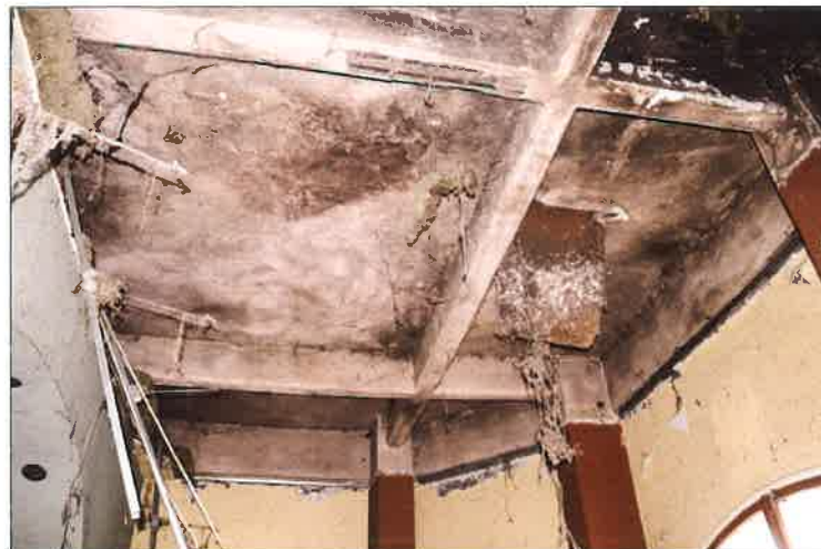
Strop żelbetowy z widocznym (po prawej stronie) wejściem na wyższe kondygnacje wieży zamaskowanym wtórnie płytą pilśniową. Oryginalna stalowa drabina prowadząca do wejścia została usunięta. (fot. Jakub Andrzejewski, 2021 r.)
