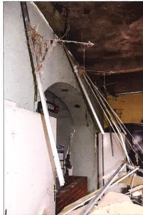
Wtórnie wykonana zabudowa z płyt karton-gips z wydzieleniem nowymi ścianami dwóch pomieszczeń i zakryciem oryginalnego stropu żelbetowego przez sufit podwieszany - obecnie zarwany. (fot. Jakub Andrzejewski, 2021 r.)
