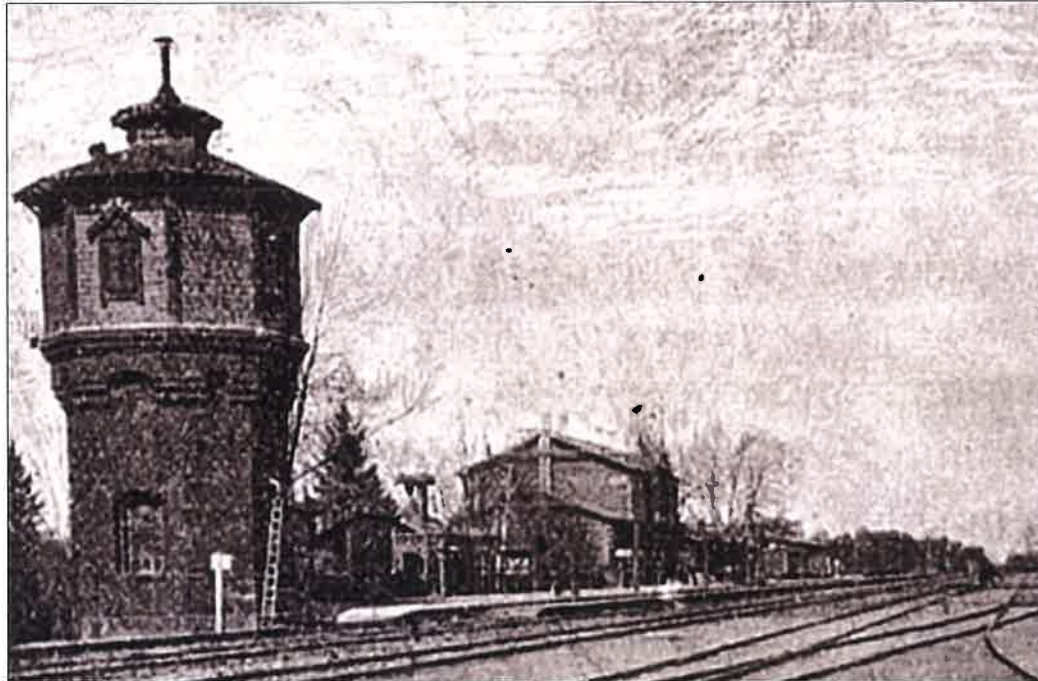
Widok ogólny stacji Otwock od strony zachodniej. Widoczna na pierwszym planie została przebudowana w 1911 r. podczas modernizacji linii Kolei Nadwiślańskiej. (źródło: https://wiedzecisnien.eu )
