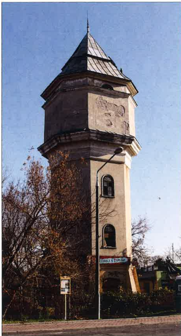
Widok budynku od strony południowej
