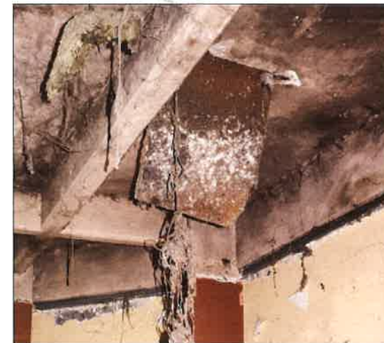
Strop żelbetowy z widocznym (po prawej stronie) wejściem na wyższe kondygnacje wieży zamaskowanym wtórnie płytą pilśniową. Oryginalna stalowa drabina prowadząca do wejścia została usunięta. (fot. Jakub Andrzejewski, 2021 r.)
