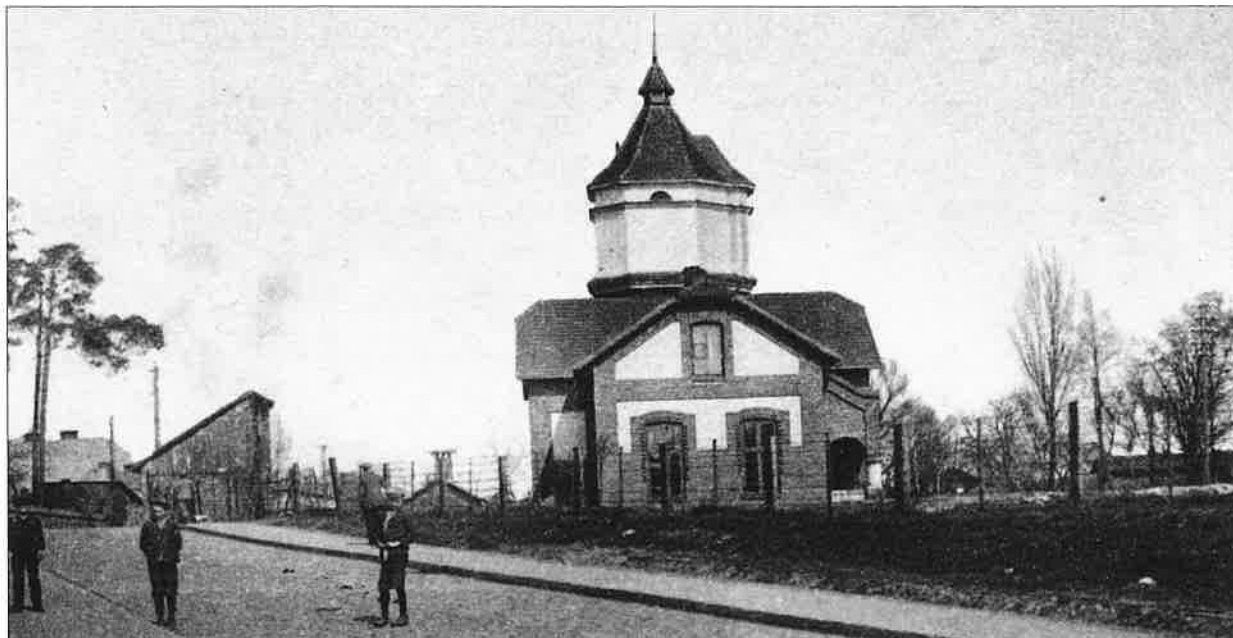
Widok wieży ciśnień w Otwocku od strony południowej i ulicy Orlej. Wykonane zdjęcie jest przypuszczalnie błędnie datowane na 1925 r. zamiast na lata 1927-1930. (źródło: https://fotopolska.eu )
