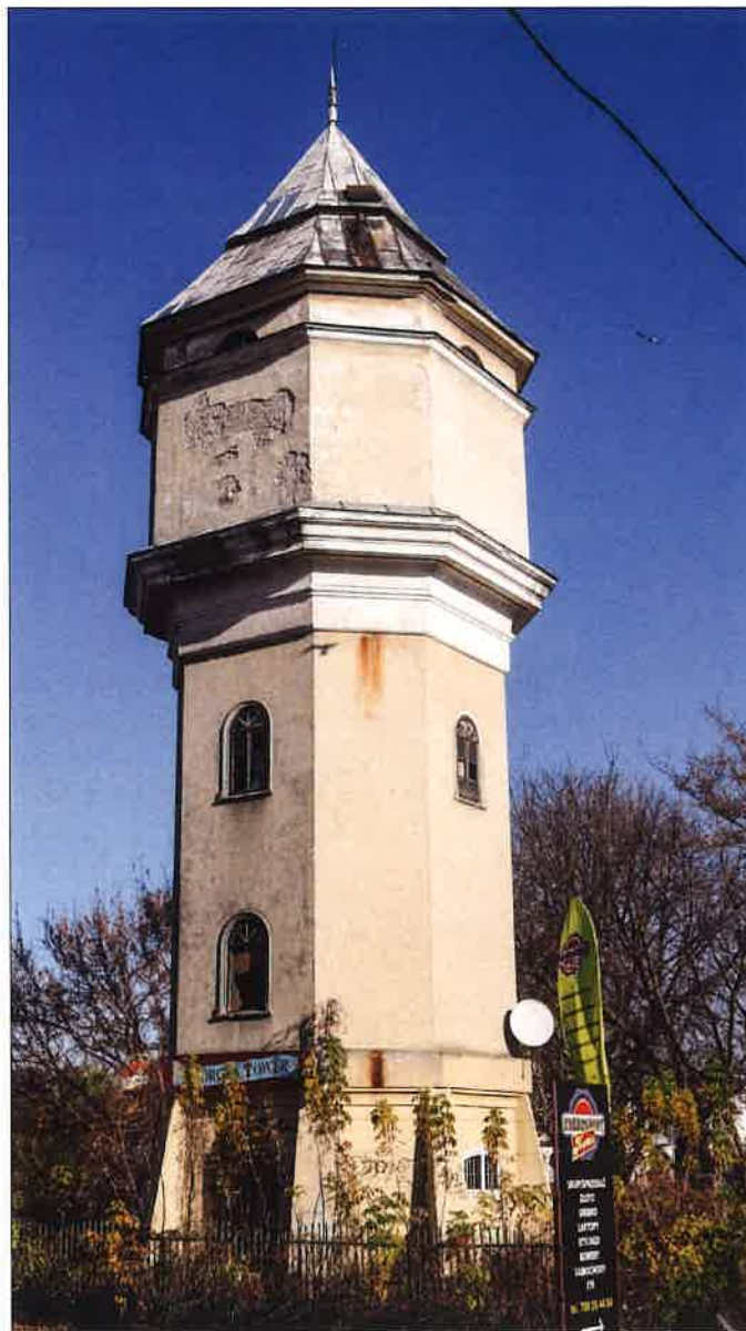
Widok wieży od strony ul. Orlej, od strony południowej. (fot. Jakub Andrzejewski, 2021 r.)
