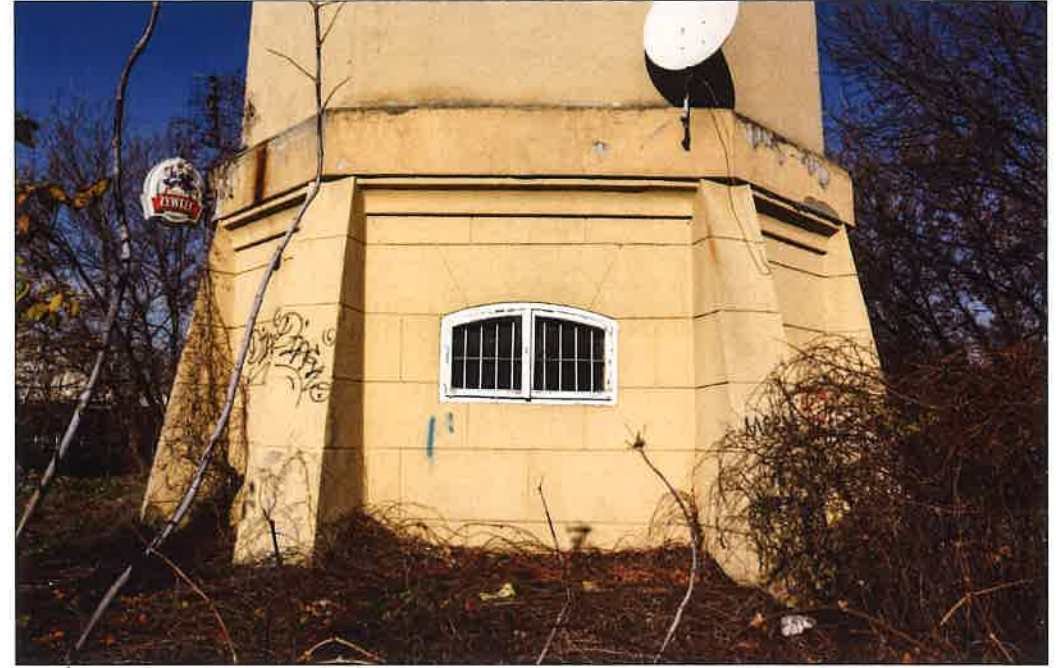
Okno w części przyziemia, w elewacji południowo-wschodniej. (fot. Jakub Andrzejewski, 2021 r.)
